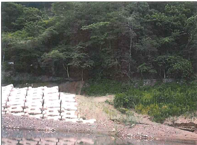
写真タイトル:取付箇所 工種:取付箇所 撮影箇所:NO. 0~下流
