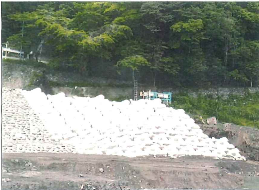
写真タイトル:進捗状況 工種:工程管理 撮影箇所:NO. 0+10. 0~NO. 2+1 0. 0
