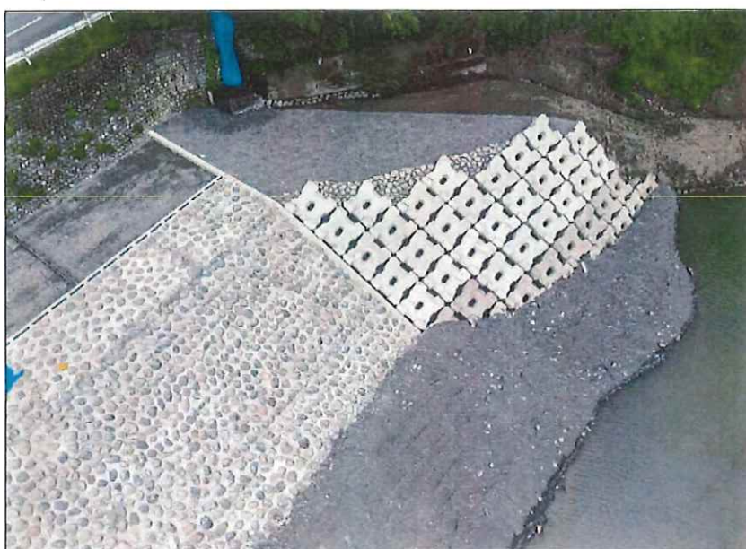
写真タイトル:現場状況 工種:護岸工
