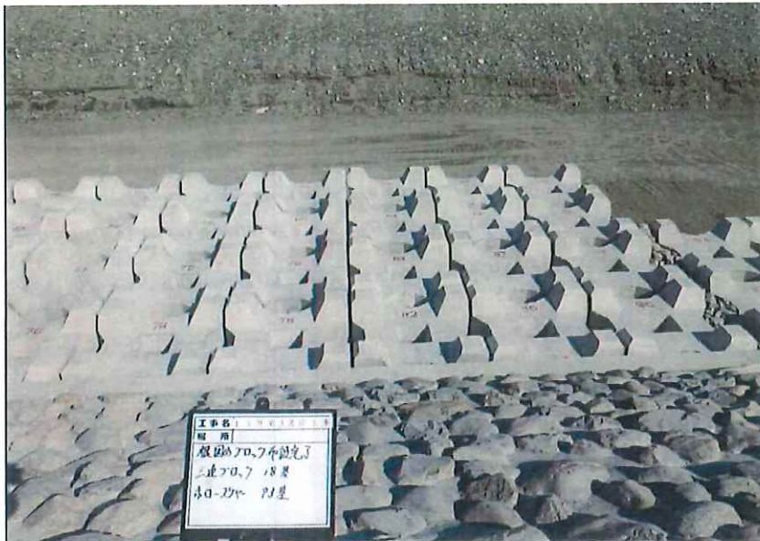
写真区分: 施工状況写真 工種: 護岸工 種別: 根固工 細別: 異形ブロック (ホロー スケヤー5t型) 写真タイトル: 布設完了
