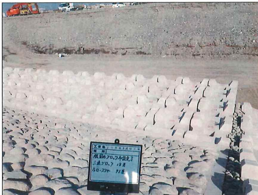
写真区分: 施工状況写真 工種: 護岸工 種別: 根固工 細別: 異形ブロック (ホロー スケヤー5t型) 写真タイトル: 布設完了
