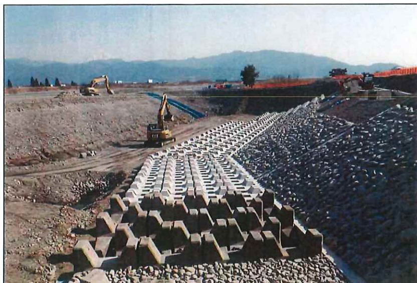
写真区分: 施工状況写真 工種: 護岸工 種別: 根固工 細別: 異形ブロック (ホロー スケヤー5t型) 写真タイトル: 布設完了
