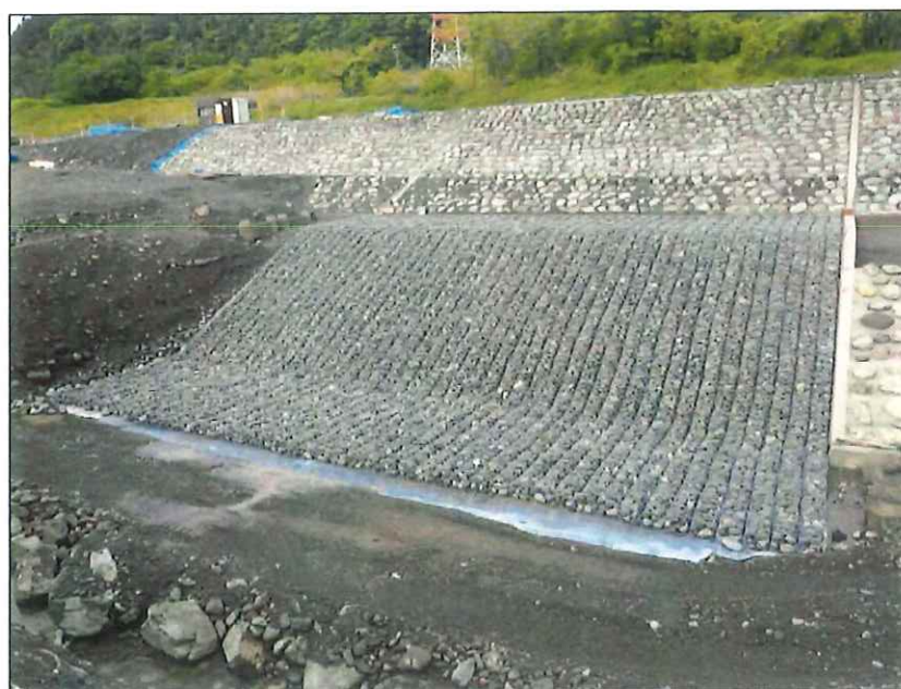
完成 鉄線蛇籠工
