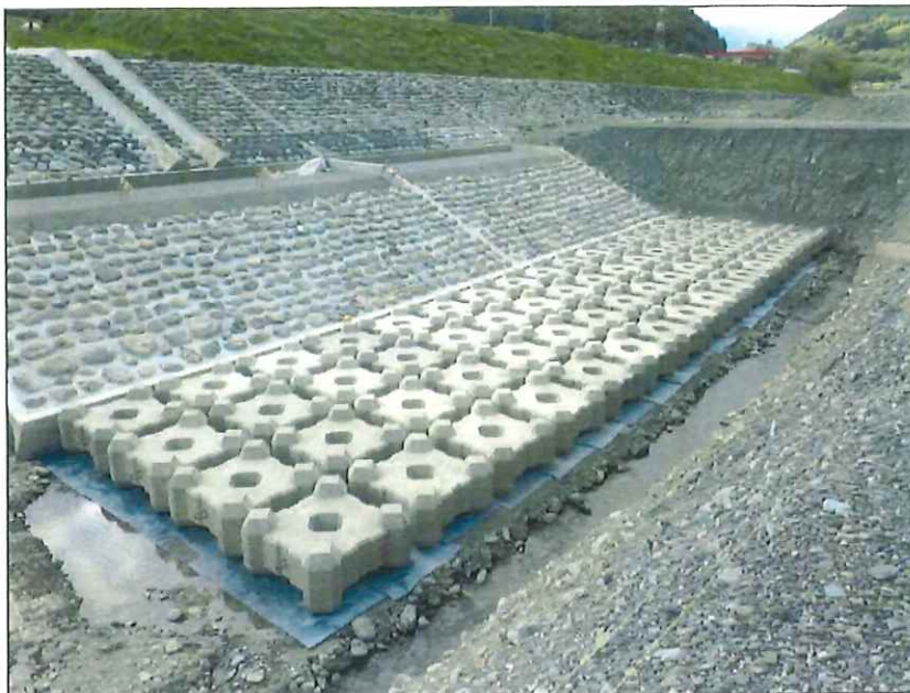
完成 根固工 (下段)
